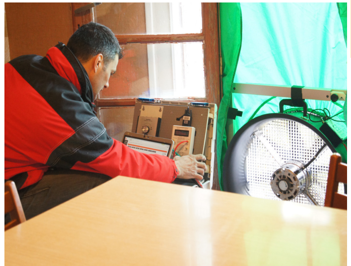
Présentation du test d'étanchéité
